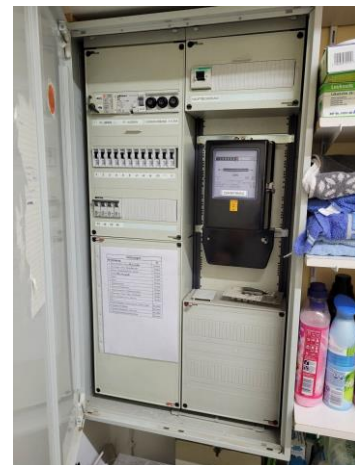
Bsp. Foto Zählerschrank
